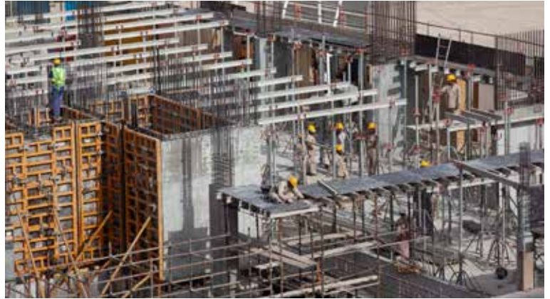
Aramco: Großbaustelle an der Gaspipeline
